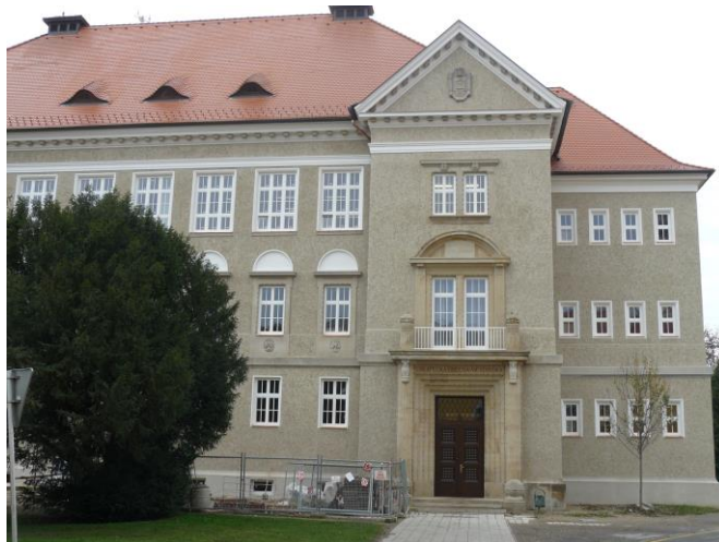
Obrázek 2 Zrekonstruovaná fasáda na čelní straně budovy
